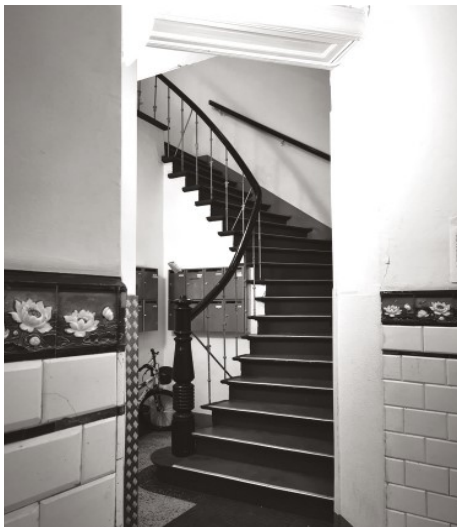
Das Treppenhaus in der Tarpenbekstraße heute (Bild © GET'21)
